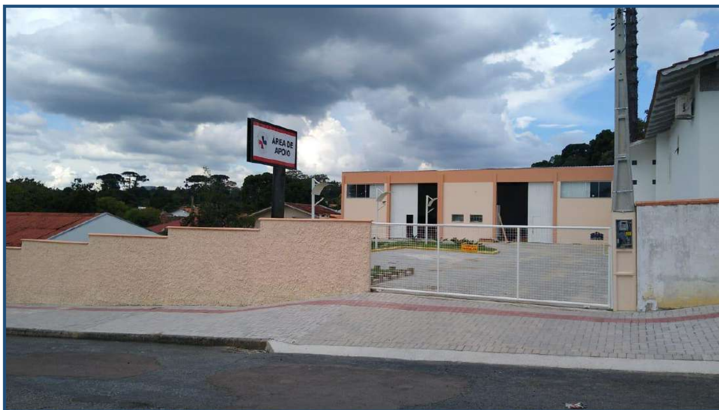
Construção do Barracão do setor de Apoio e do SAME
