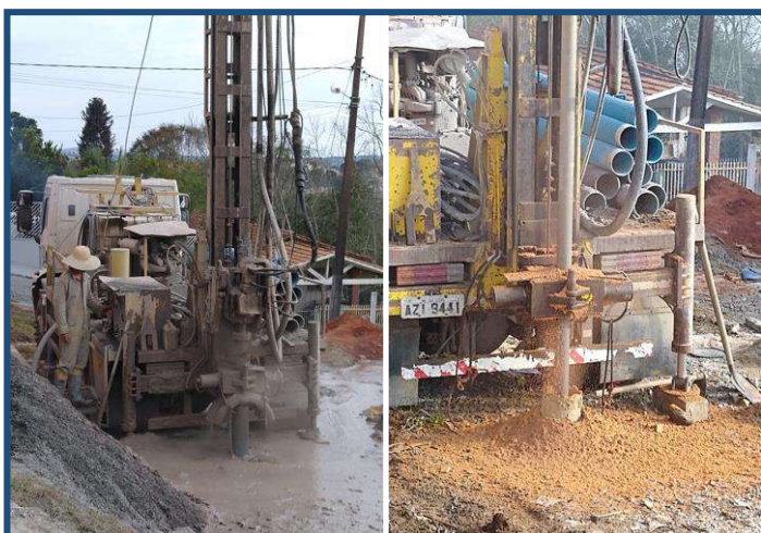
Novo Poço Artesiano
