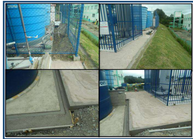
Obras em Torno do Tanque de Oxigênio
