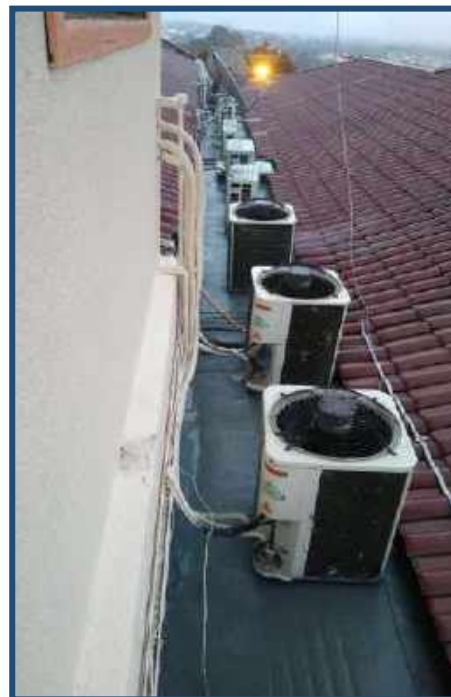
Impermeabilização laje e corredor da rampa do SUE que estava com infiltração
