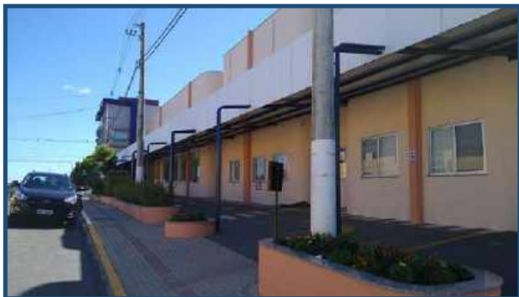
Instalação de Toldo na frente do Centro Clínico
