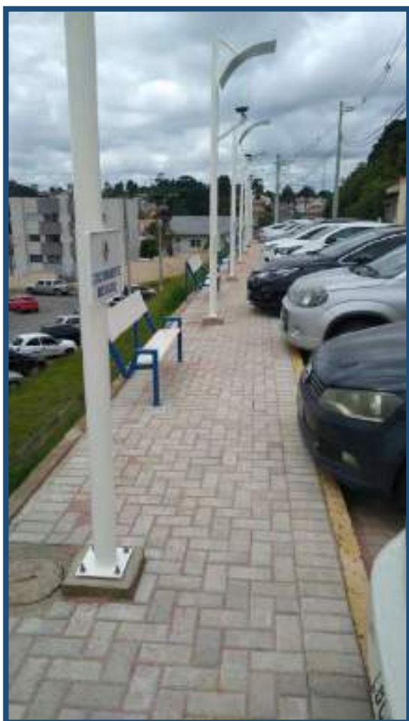
Manutenção no estacionamento HSVP, postes, banco e paver
