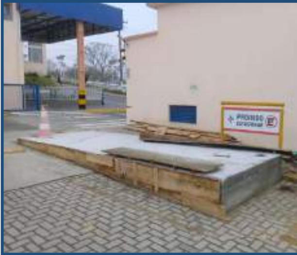
Base para relocação gerador para obra novo prédio
